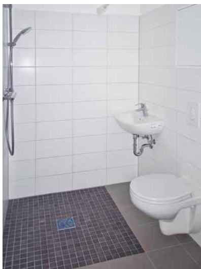
Neues Bad mit bodengleicher Dusche.
