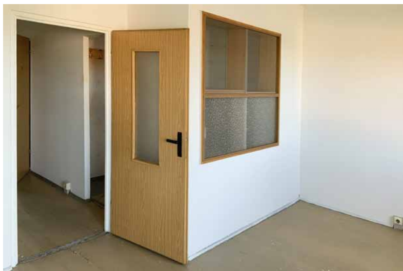
Vor der Sanierung: Die kleine Küche mit Durchreiche zum Wohnzimmer.
