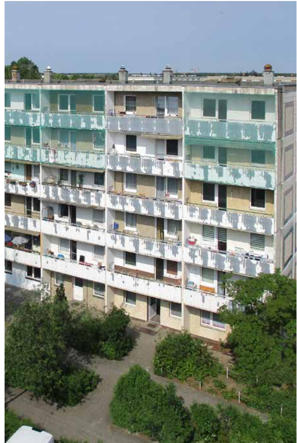
Fassade Wladislaw-Wolkow-Straße vor der Sanierung
