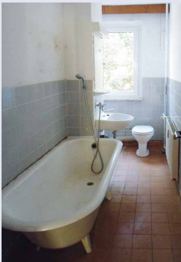
Das Badezimmer mit Wanne vor der Sanierung.
