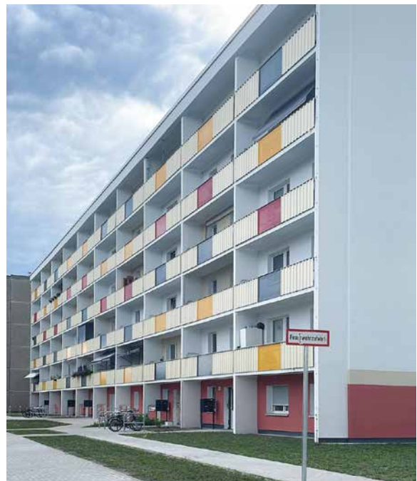
Fassade Wladislaw-Wolkow-Straße nach der Sanierung
