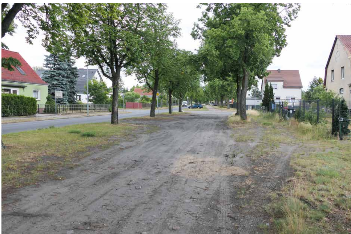
Julian-Marchlewski-Straße, früher Damaschkestraße Foto: F. Wilke 2026
