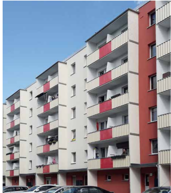
Fassade der Wladislaw-Wolkow-Straße 29–35 nach der Sanierung
