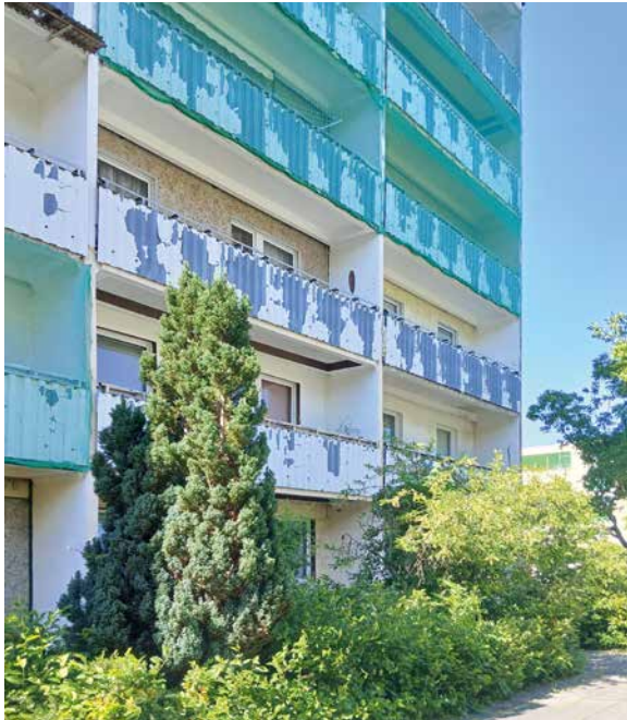
Fassade der Wladislaw-Wolkow-Straße 19–23 vor der Sanierung
