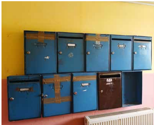
Briefkästen vor der Sanierung
