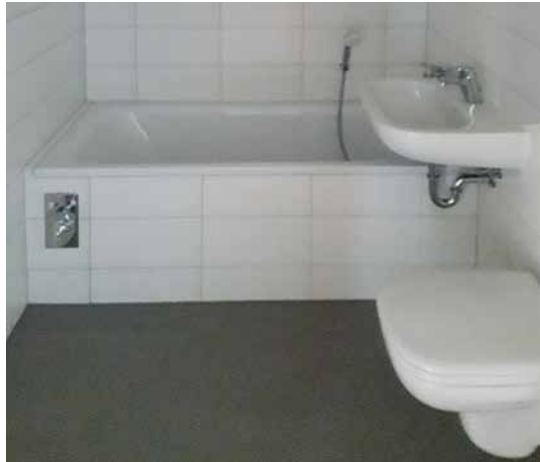
Bad nach der Sanierung
