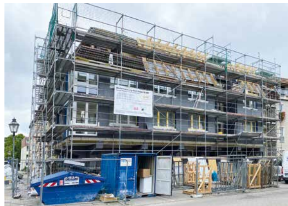
Das Haus während der Sanierungsarbeiten
