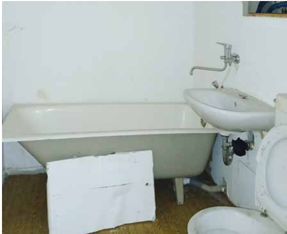
Badezimmer vor der Sanierung
