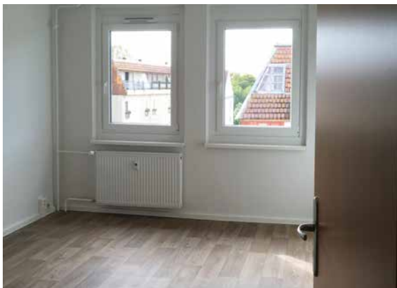
Zimmer mit neuen Fenstern, Heizkörper und Laminatfußboden in Holzoptik nach der Sanierung
