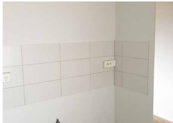
Fliesenspiegel in der Küche nach der Sanierung
