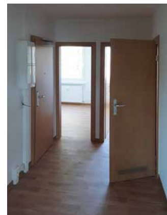
Flur nach der Sanierung
