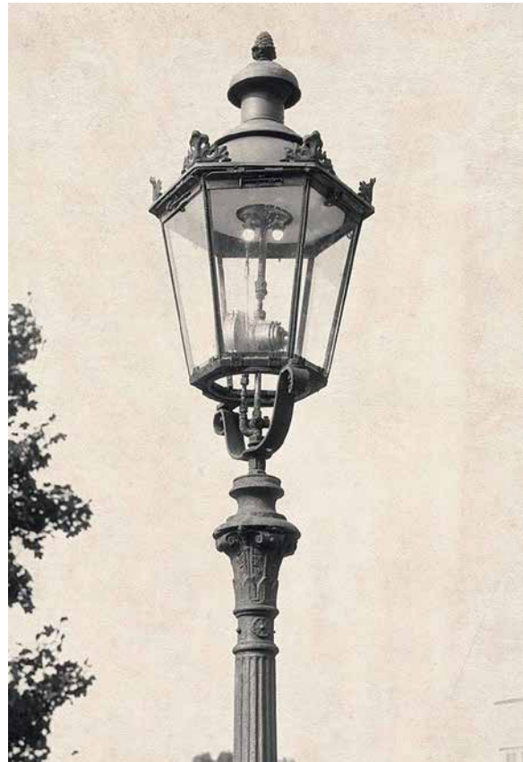
Eine Schinkelleuchte, der Laternentyp, der in Fürstenwalde üblich war. Gut erkennbar sind die Glühstrümpfe. ©Erdgas Schwaben
