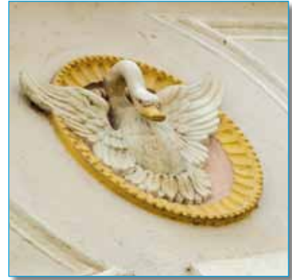
Historisches Stuckfassadenelement an der Dr.-Wilhelm-Külz-Straße 43
